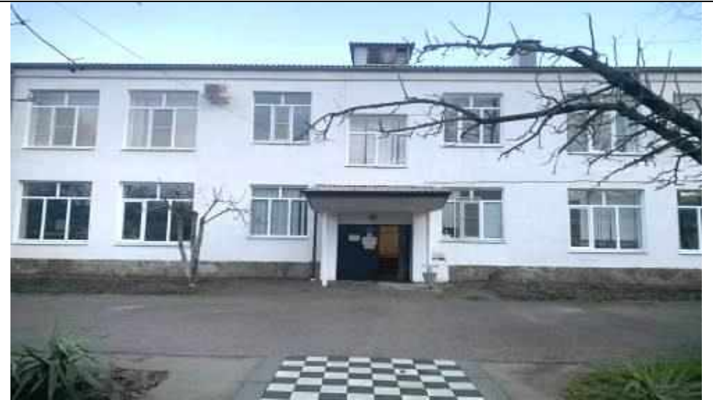
Здание учебного корпуса
